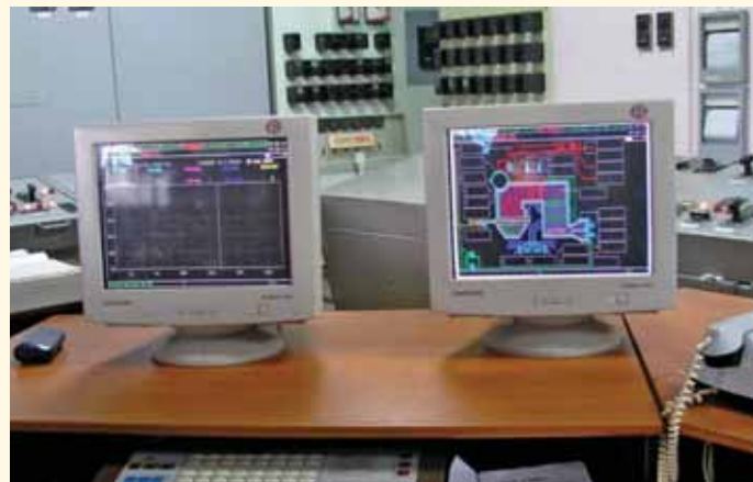
Автоматизована система автоматичного керування паровим котлоагрегатом
