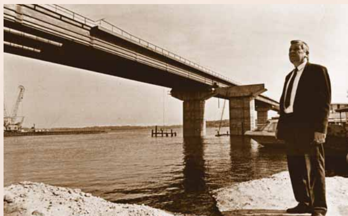
Будівництво мосту через р. Дніпро у м. Дніпродзержинську, 1994 р.
