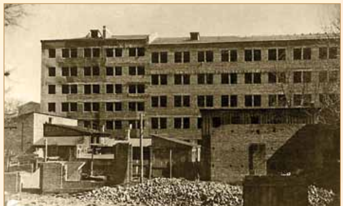
Будівництво гуртожитків, 50-ті рр. XX ст.
