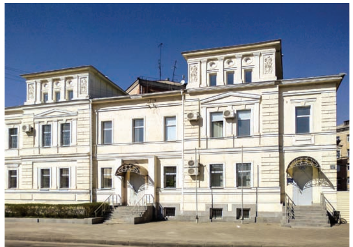
Будівля Інституту перепідготовки та підвищення кваліфікації кадрів
