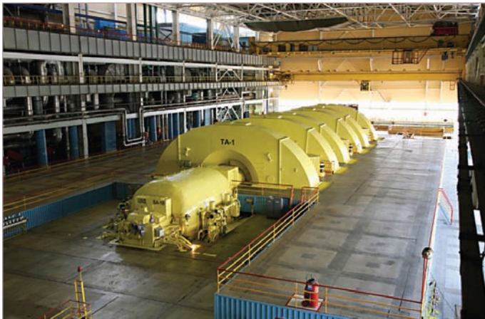
Турбіна потужністю 1 млн кВт, створена на ВАТ «Турбоатом» за участю випускників спеціальності «ДММ»
