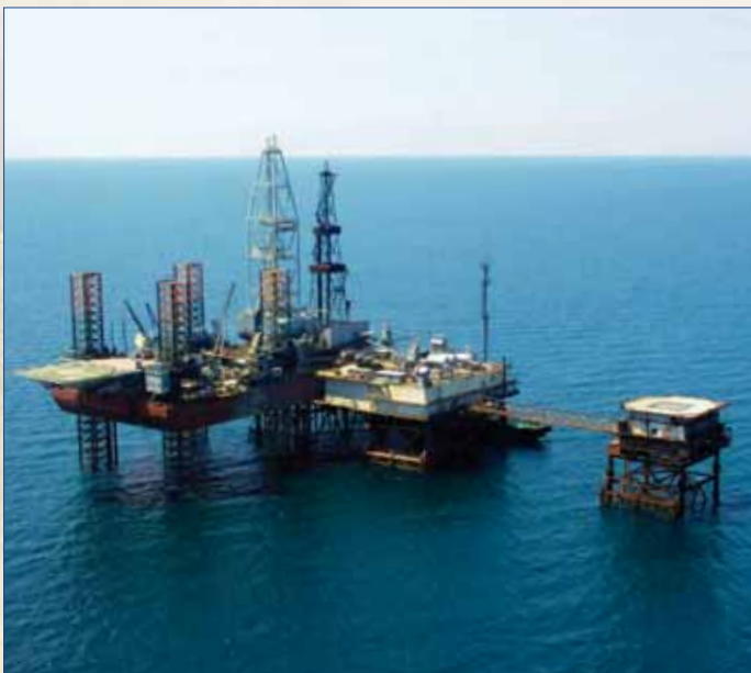
Загальний вигляд блок-кондуктора БК-23 Штормового ГКР
