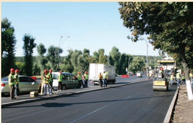
Виконання робіт із реконструкції проспекту Перемоги, м. Київ
